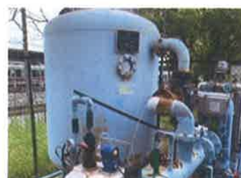
3. ウォーターランドろ過ポンプ 濾材更新工事
