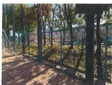
4. 球技場防球フェンス張替え他工事
