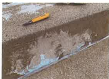
1. ウォーターランド漏水対策工事
