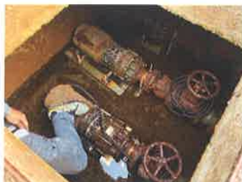
2. ウォーターランドポンプ更新工事
